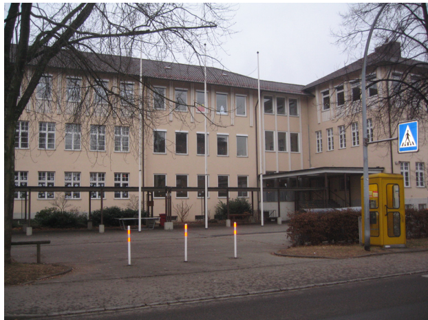
Abb.2: Die Grund- und Hauptschule Lindau Reutin: einer der vielen kommunalen Klimakiller in Lindau
