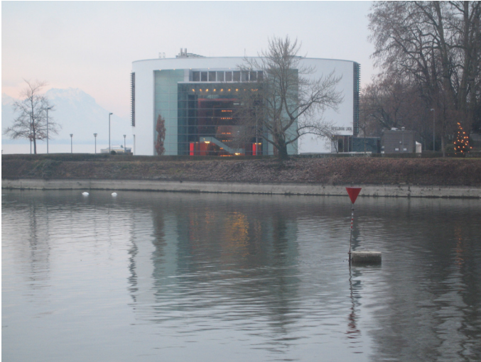
Abb.4: Das jüngste öffentliche Gebäude in Lindau war schon zu seiner Fertigstellung ein energetischer Sanierungsfall: die Lindauer Spielbank
